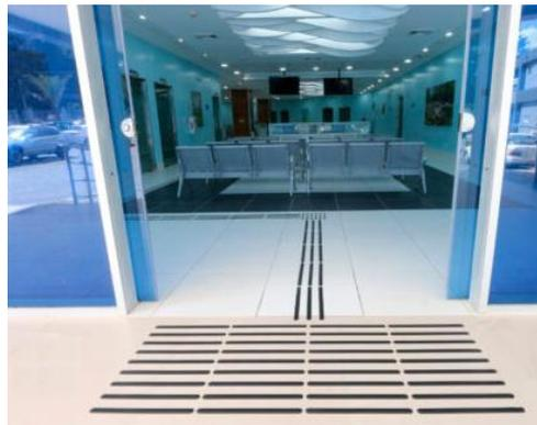
Guías autoadhesivas para encaminamiento y avisos podotáctiles
